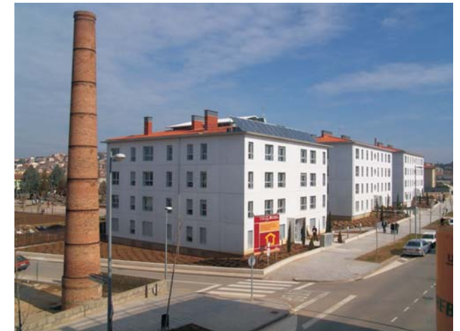
Vista del conjunt
