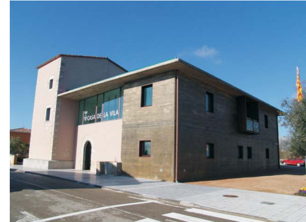
Vista façana est
