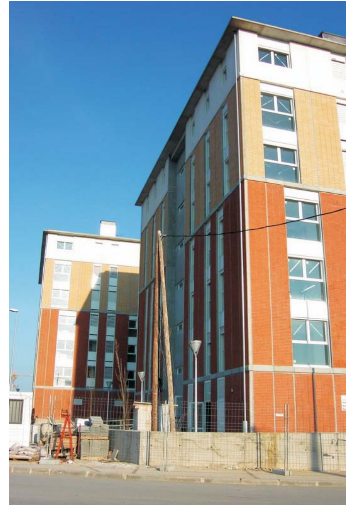
Vista del conjunt
