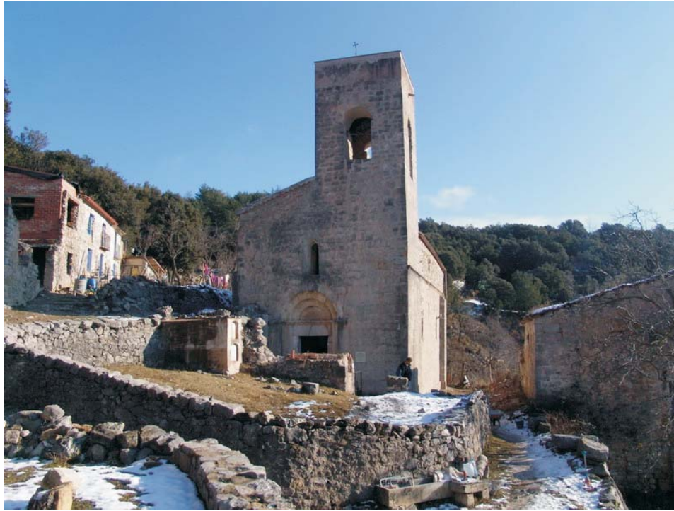
vista del conjunt
