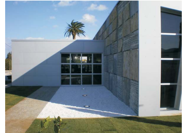
Vista façana oest
