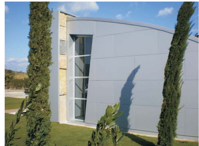
Vista façana oest
